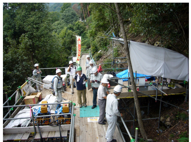
作業足場上から見学
