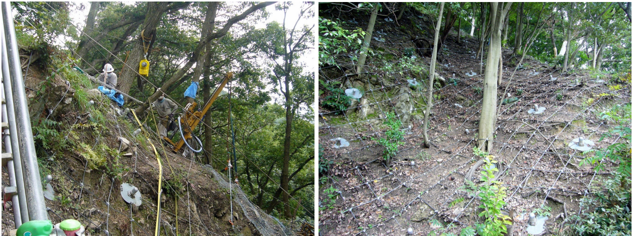
施工状況写真（左）削孔機械 （右）完成箇所
