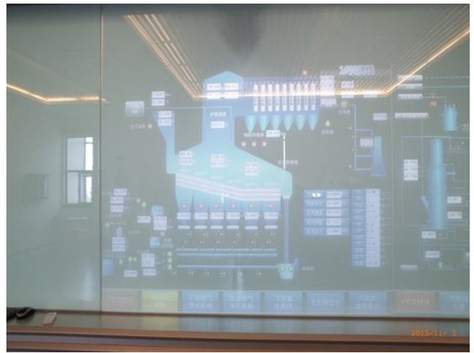
ゴミ発電運転データ表示
