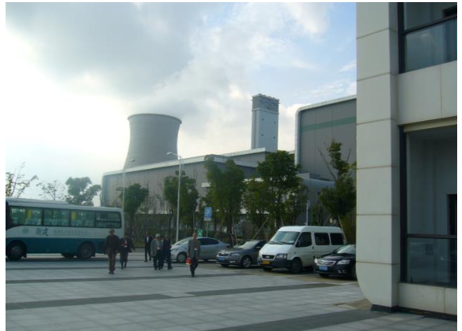
上海老港再生能源利用中心のごみ焼却炉
