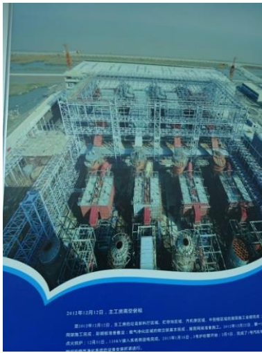
上海老港建設中 鳥瞰図
