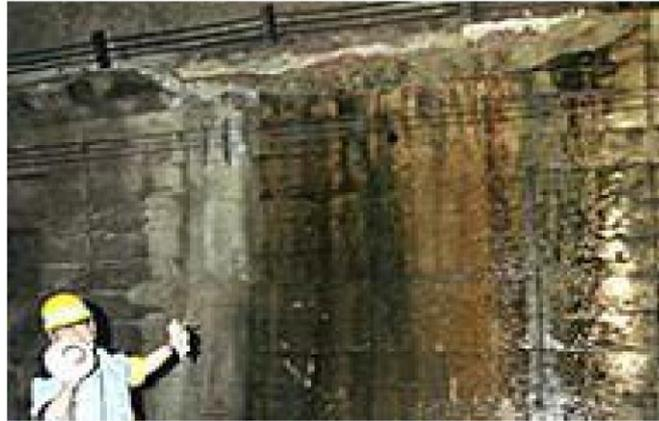
写真-2 北九州トンネル剥落
