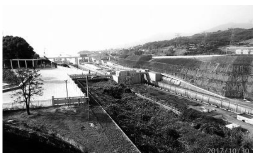
図8c 船舶用閘門上流側の遠景
