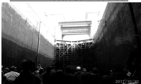
図 4a 上流側扉閉鎖中（船首側）
