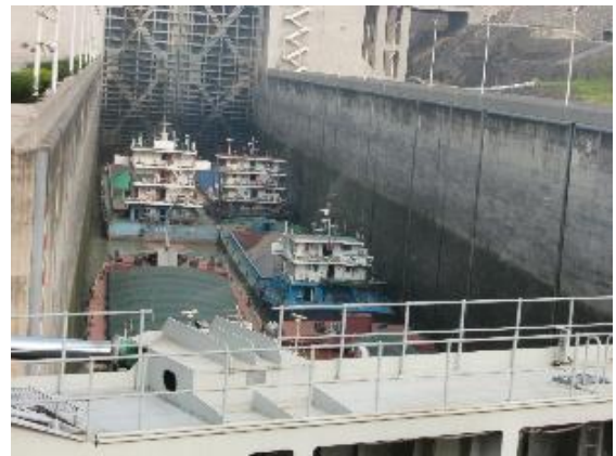
写真 11：閘門を通行中の船舶
