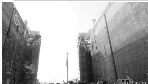
図 4b 下流側扉閉鎖開始（船尾側）
