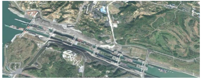
写真 10：5 段の閘門 (シップロック) 全景
