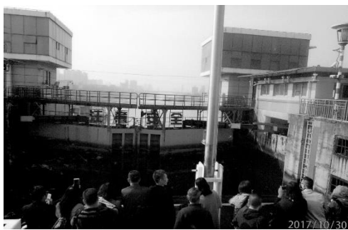
図 4c 下流側扉閉鎖完了（船尾側）
