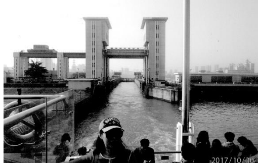
図 4d 関門離脱（タワー部分が扉位置）
