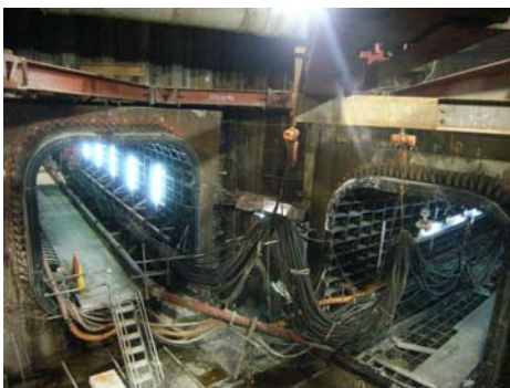
完成した東側・北側通路
